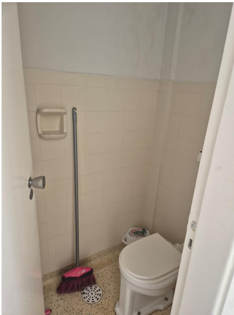
FOTO N.º 10- Detalhe interno do banheiro de n.º 01.
