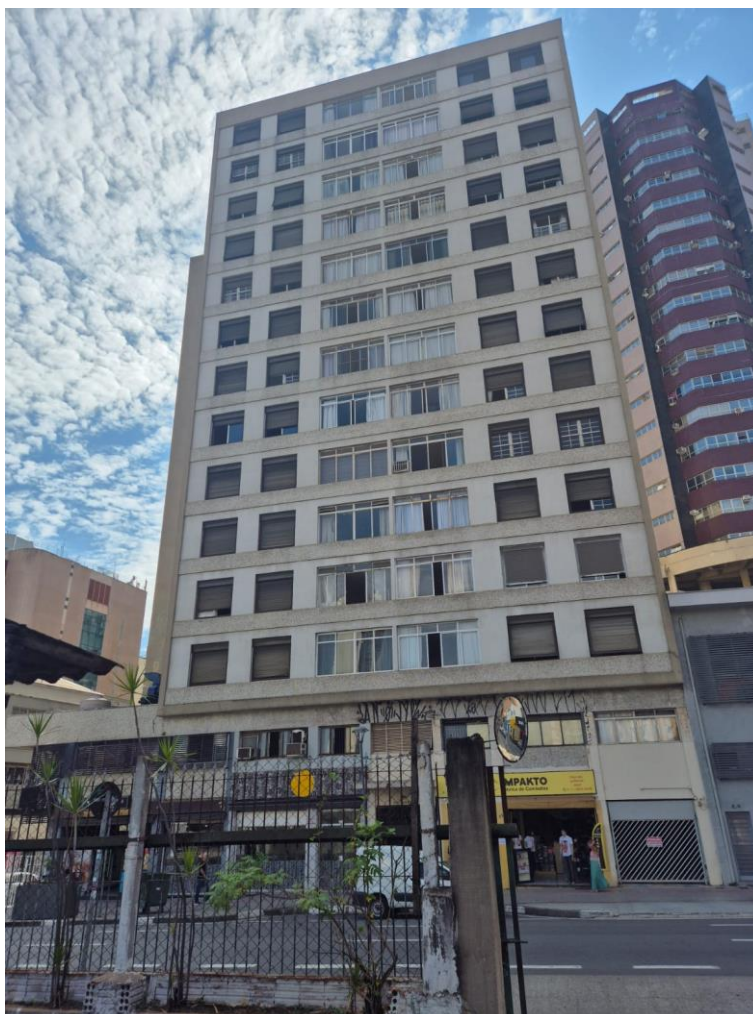
FOTO N.º 01- Tomada da fachada do Edifício Cannes, com frente para Av. Francisco Glicério, n.º 694.
