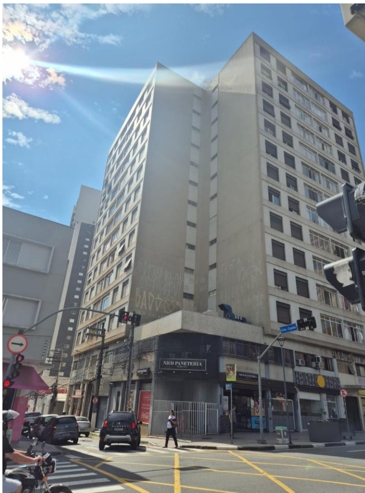
FOTO N.º 02- Detalhe da fachada do Edifício Cannes, na esquina da Av. Francisco Glicério, com a Rua Cônego Cipião.
