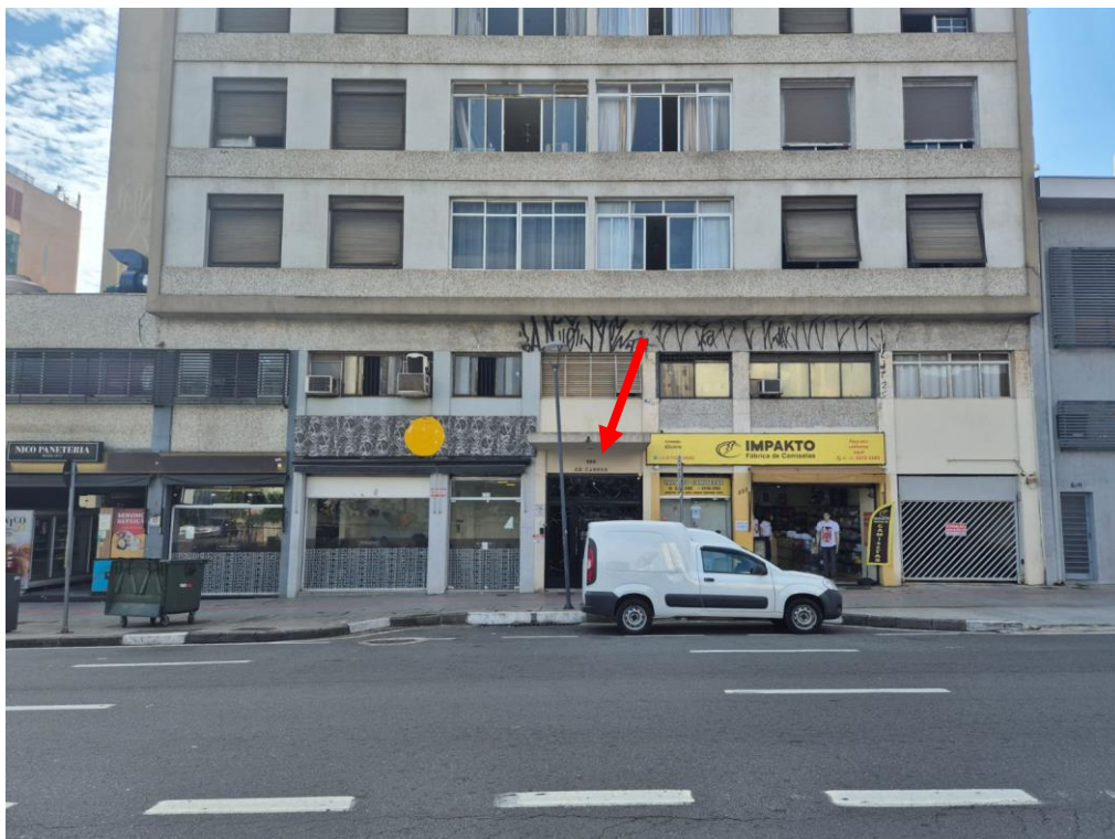
FOTO N.º 03- Aspecto da portaria de acesso ao edifício Cannes.
